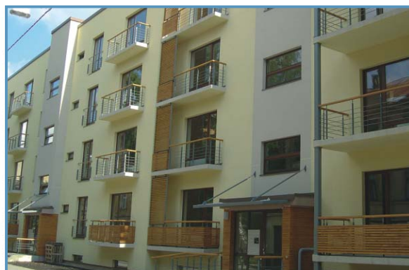
Dzīvokļu ēka Pārdaugavā, Nometņu iela 32/34
